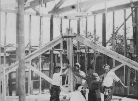
建築中の江守商店店舗
